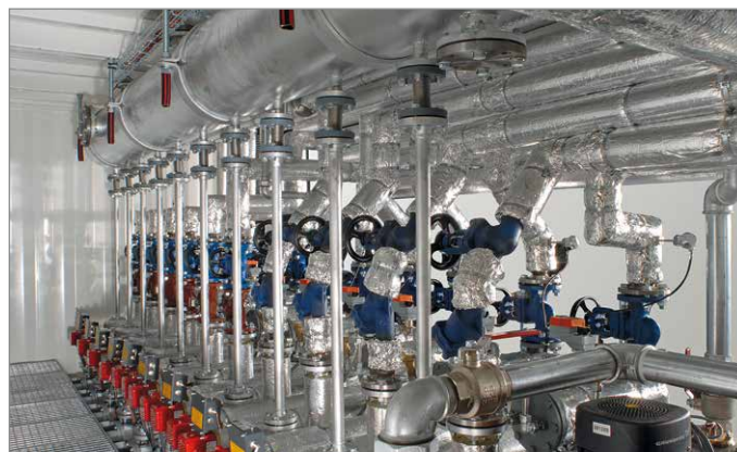
Widok kontenera od wewnątrz.
